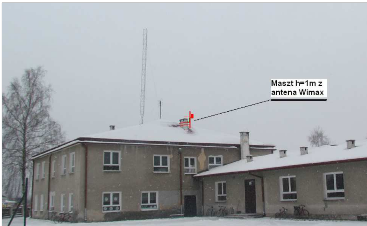
Rys. IV.60. Miejsce montażu masztu i anteny na dachu budynku
