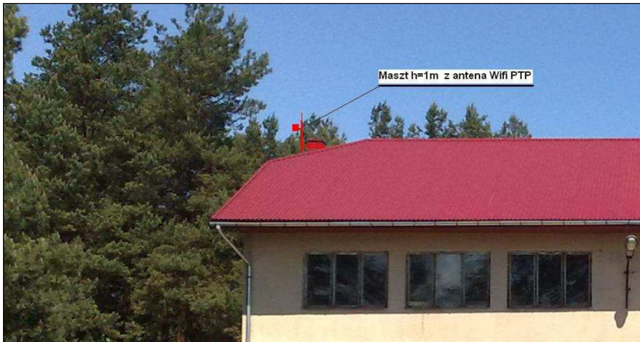
Rys. IV.62. Miejsce montażu masztu i anteny na dachu budynku
