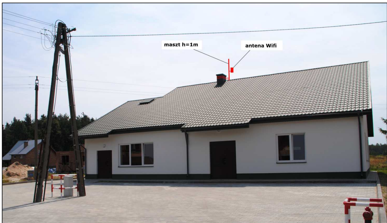
Rys. IV.58. Miejsce montażu masztu i anteny na dachu budynku
