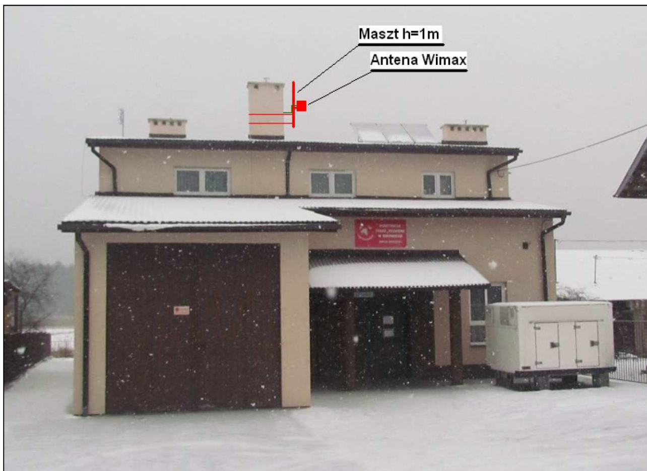
Rys. IV.50. Miejsce montażu masztu i anteny na dachu budynku
