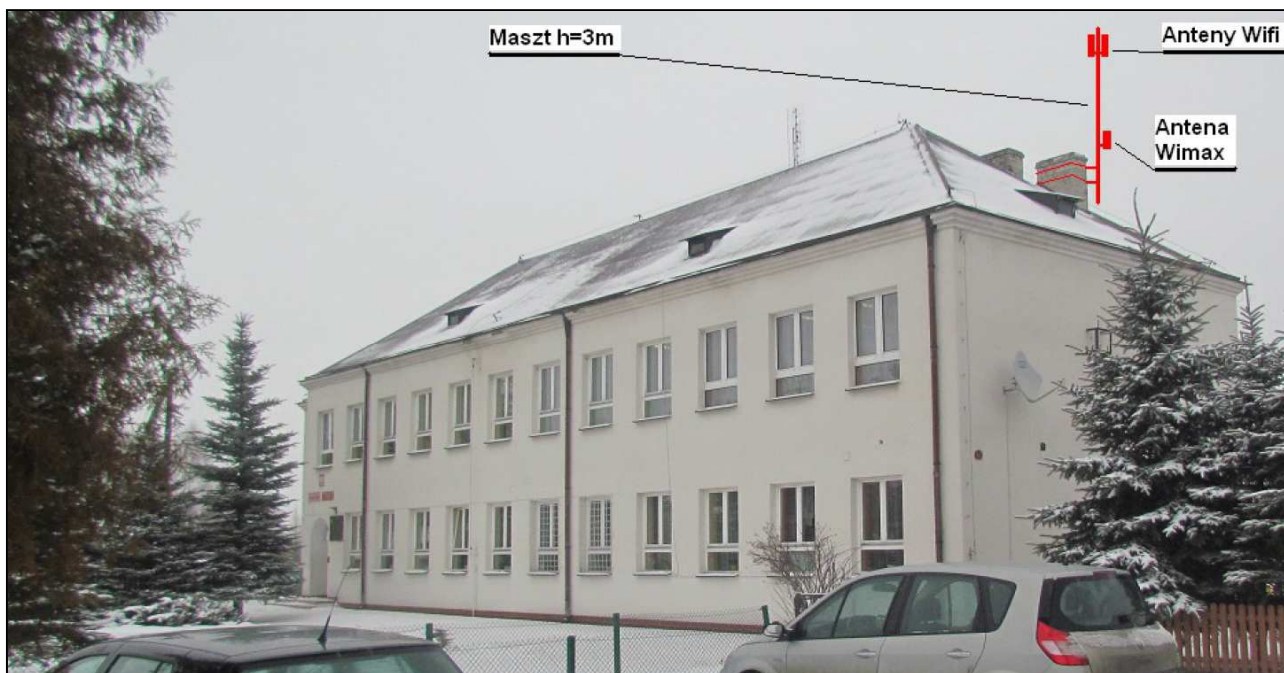
Rys. IV.55. Miejsce montażu masztu i anten na dachu budynku
