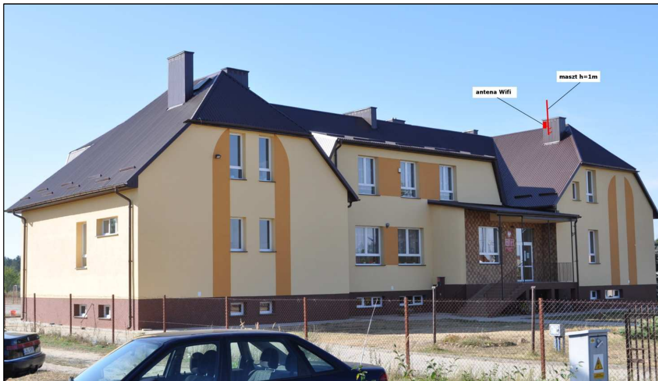
Rys. IV.51. Miejsce montażu masztu i anteny na dachu budynku
