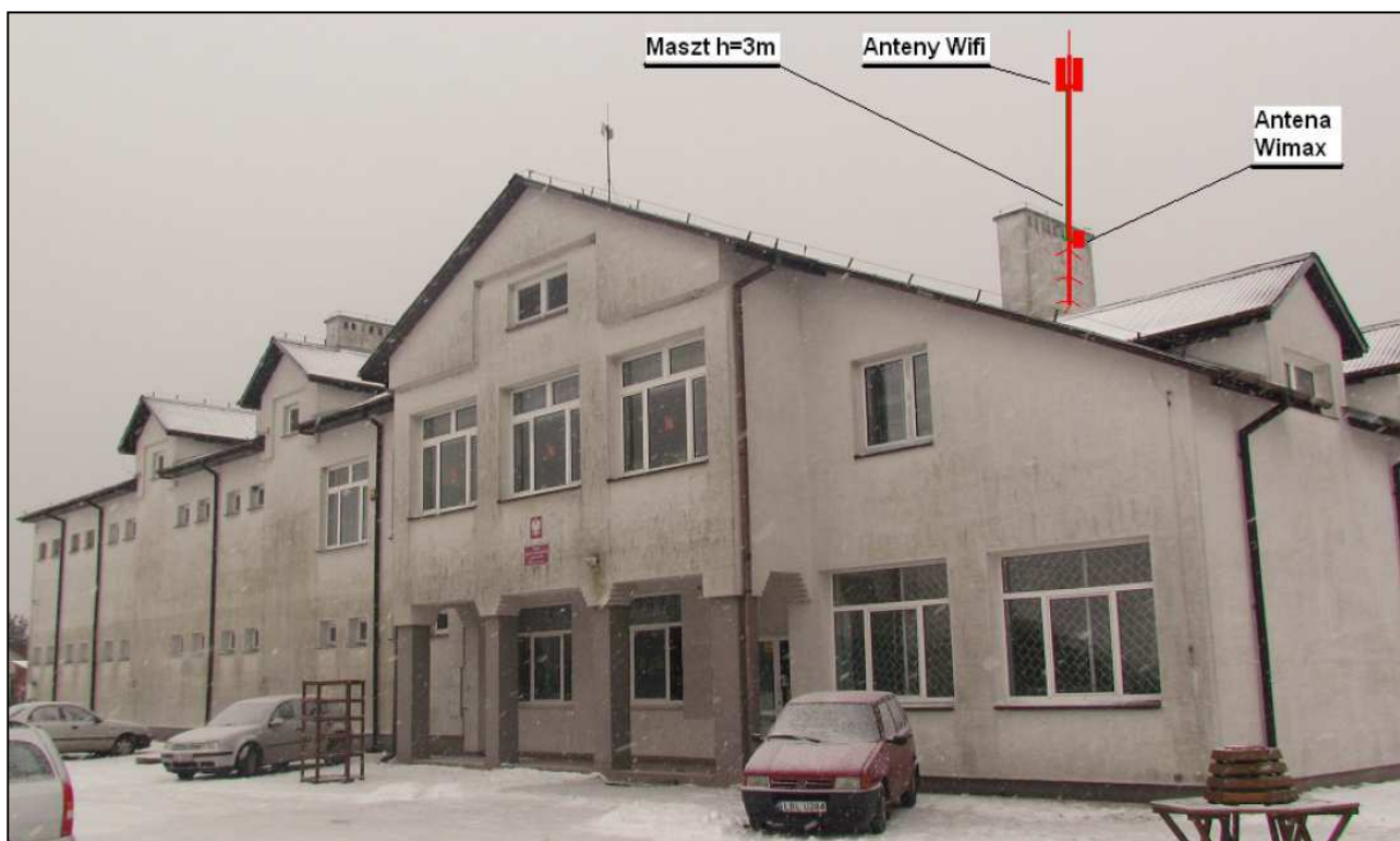
Rys. IV.53. Miejsce montażu masztu i anten na dachu budynku
