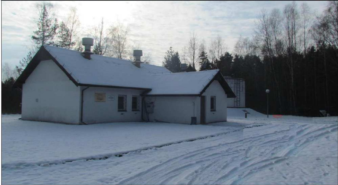
Rys. IV.5. Miejsce montażu kotew na odciągi
