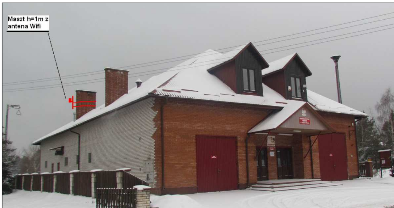
Rys. IV.59. Miejsce montażu masztu i anteny na dachu budynku
