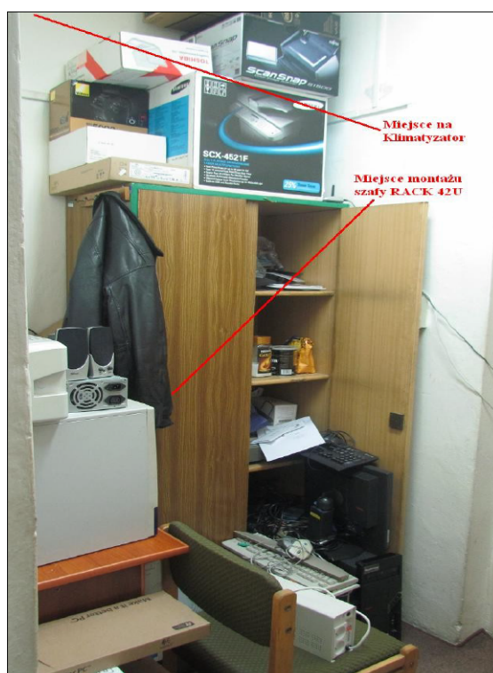
Rys. IV.1. Pomieszczenie do adaptacji na sprzęt teleinformatyczny w GPD
