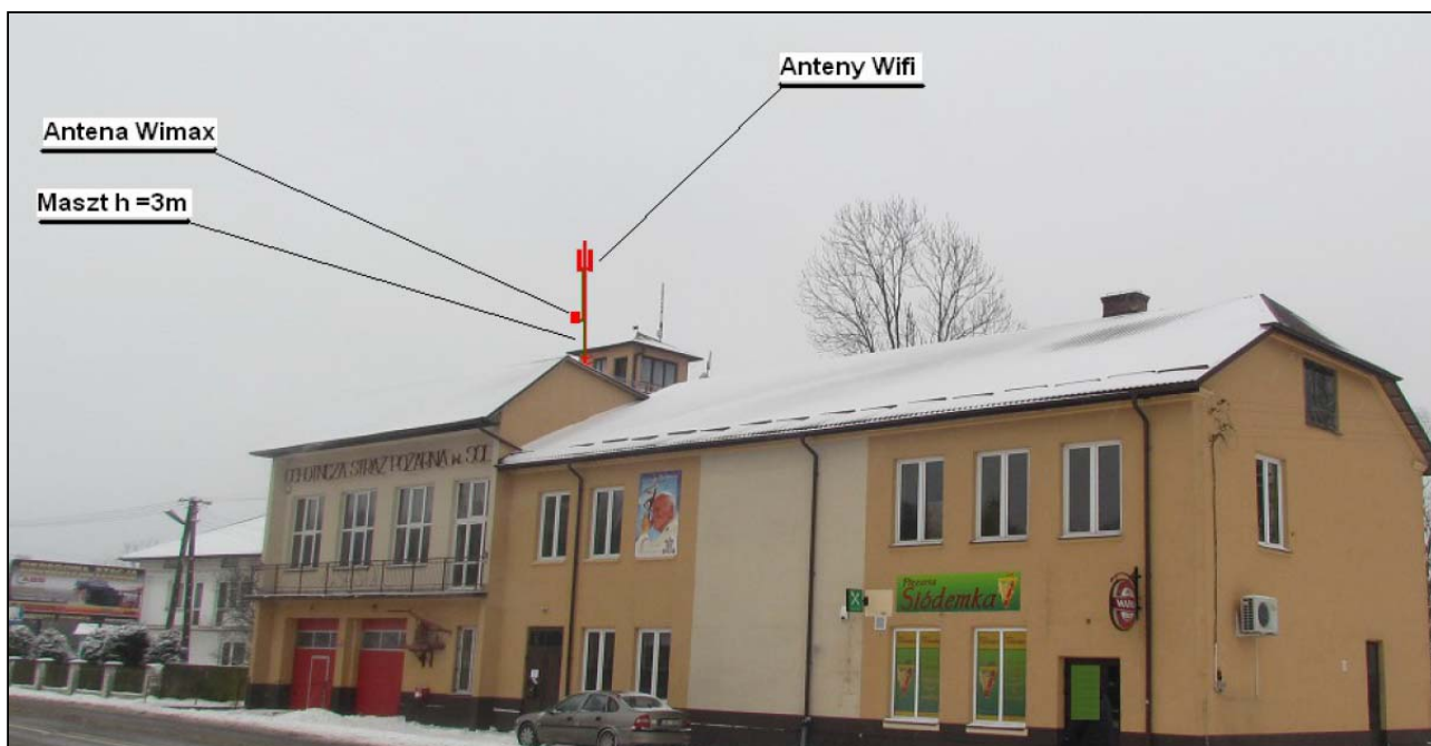
Rys. IV.56. Miejsce montażu masztu i anteny na dachu budynku
