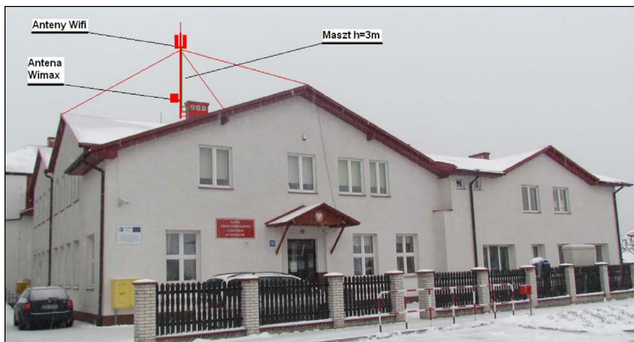
Rys. IV.49. Miejsce montażu masztu i anten na dachu budynku
