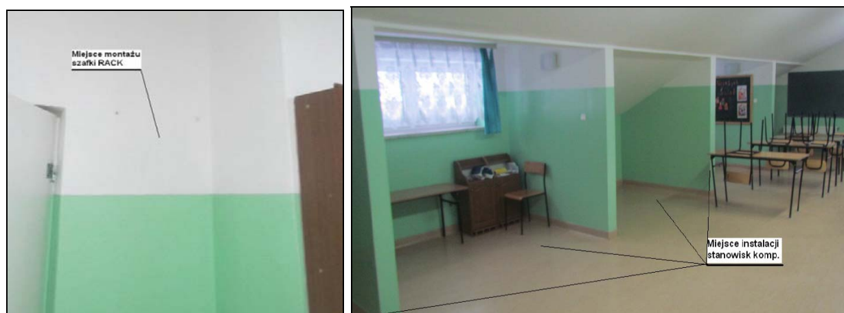
Rys. IV.54. Miejsce montażu szafki RACK oraz stanowisk komputerowych
