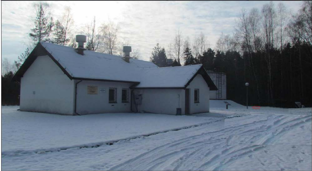
Rys. IV.5. Miejsce montażu kotew na odciągi
